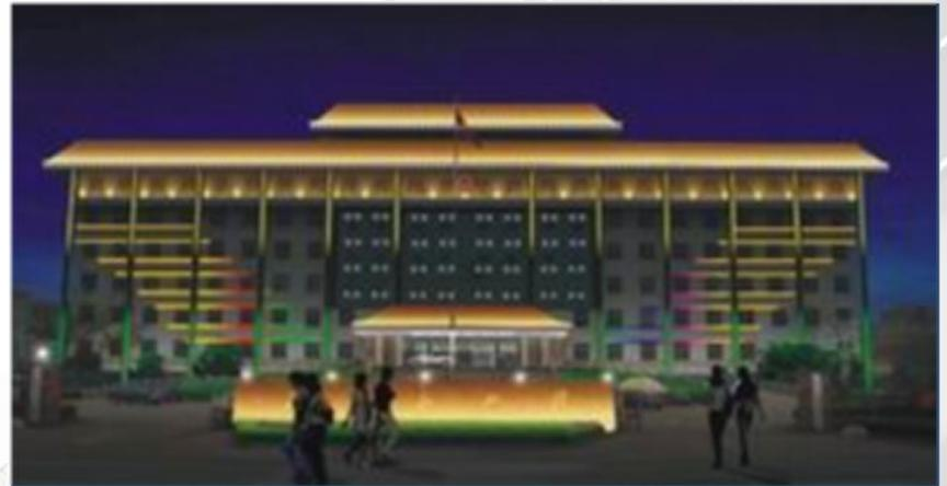
通过智能照明控制系统，可进行时间控制，根据傍晚、夜晚、深夜设置场景。傍晚来临时，室外照度逐渐减弱，可开启部分照明回路，以凸显建筑物风格；当夜晚来临，开启所有的泛光照明；在深夜后，关闭大部分的泛光照明回路，仅保留部分回路。系统处于全自动控制，并且所有控制程序可由工作人员可以随时灵活更改。大楼内照明可按照工作时间进行定时开关或人体感应进行控制，从而达到舒适、节能的目的。
